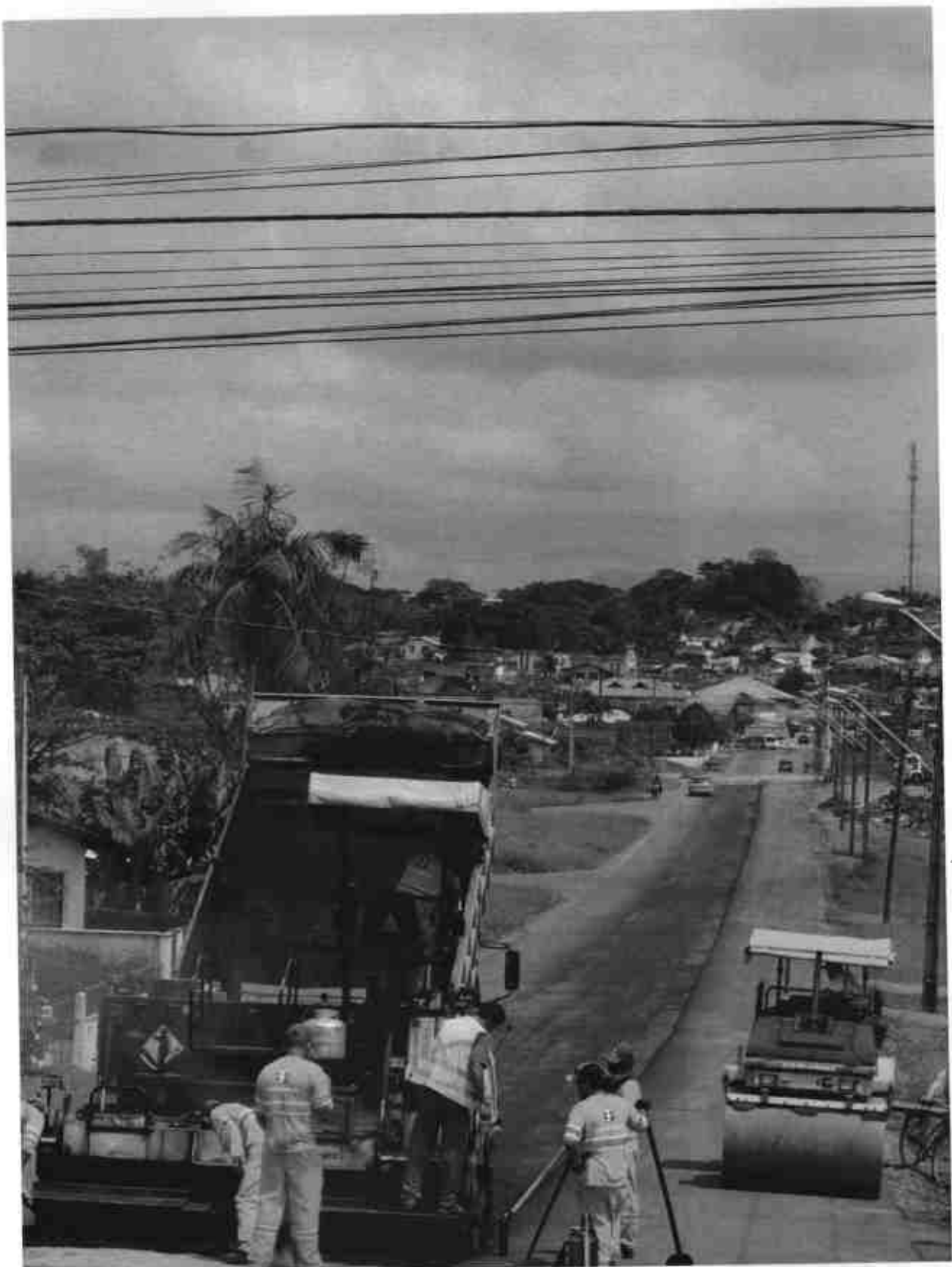
Quarenta e oito ruas da cidade terão obras de pavimentação
