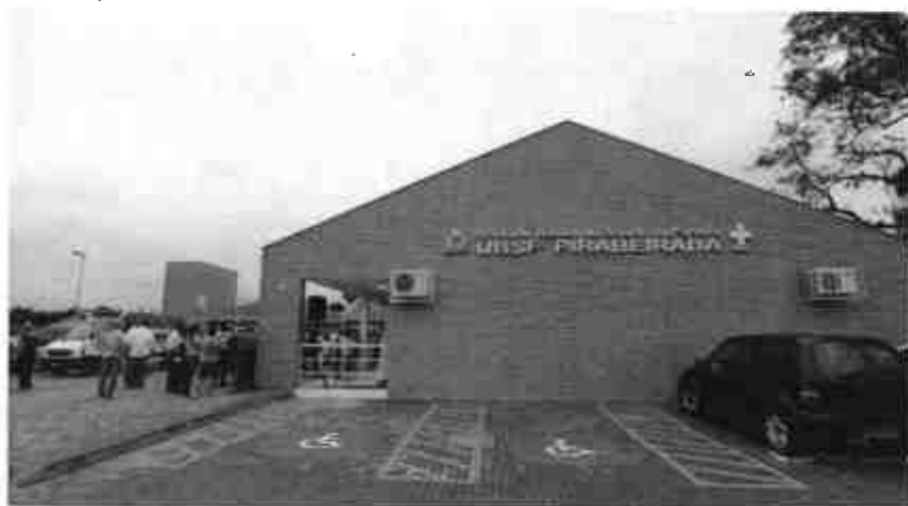
Instalações da UBSF Pirabeiraba
