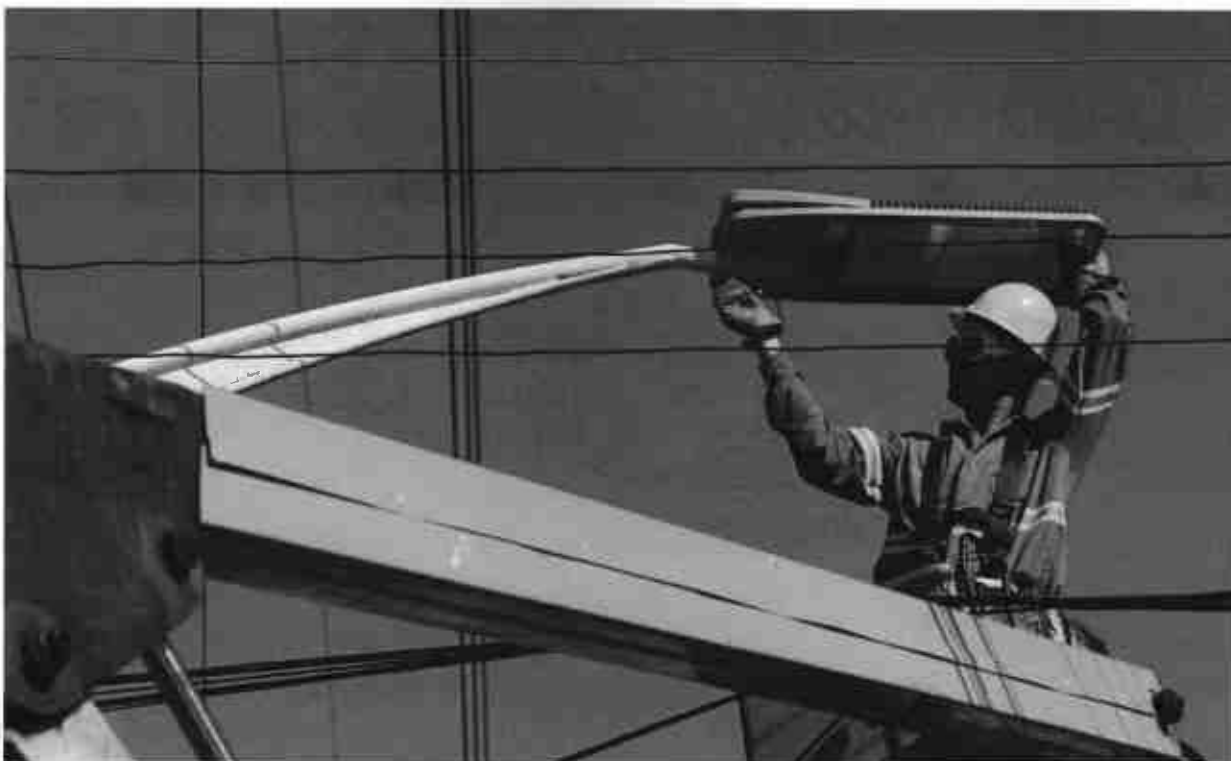
Instalação de lâmpadas de LED
